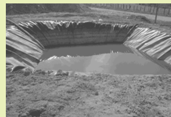
Fig. 3 - Lagoa de estabilização, sem cobertura
