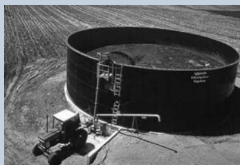
Fig. 2 - Tanque acima da superfície do solo, sem cobertura
