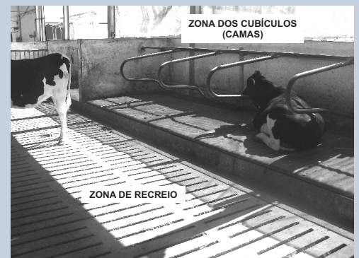
Exemplo de estabulação livre em cubículos com pavimento em grelha (produção de chorume).
