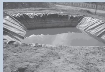
Fig. 3 - Lagoa de estabilização, sem cobertura
